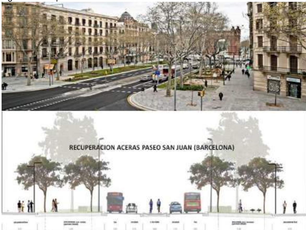
Figura 16 Recuperación de aceras
